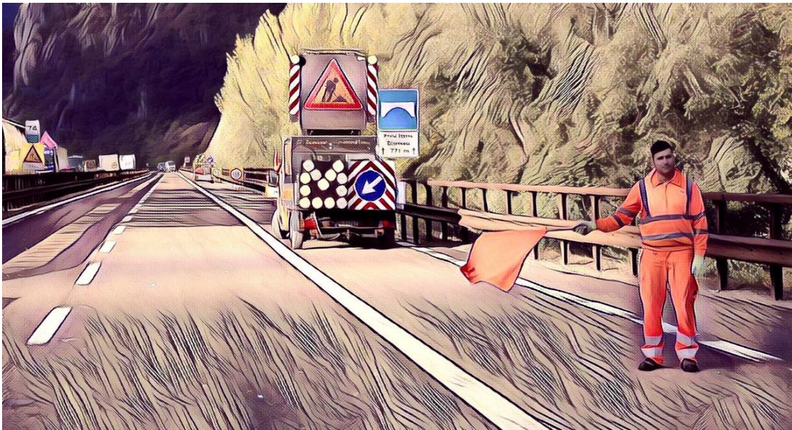
Chiusura della corsia di sorpasso: presegnalazione per l'installazione della segnaletica in avvicinamento
