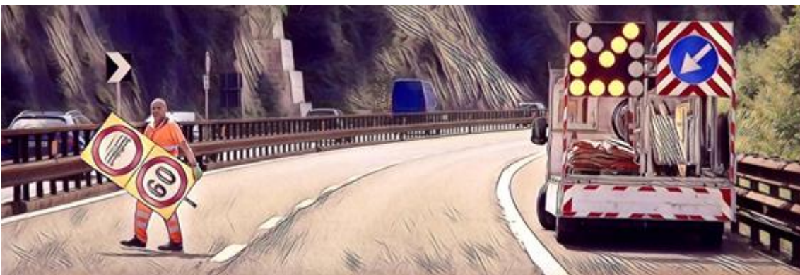
Chiusura della corsia di sorpasso: attraversamento per installazione del segnale sul margine sinistro con un solo operatore (nel caso di 2 operatori il secondo operatore si pone dalla parte opposta del primo per contrastare al meglio il possibile l'“effetto vela”).
