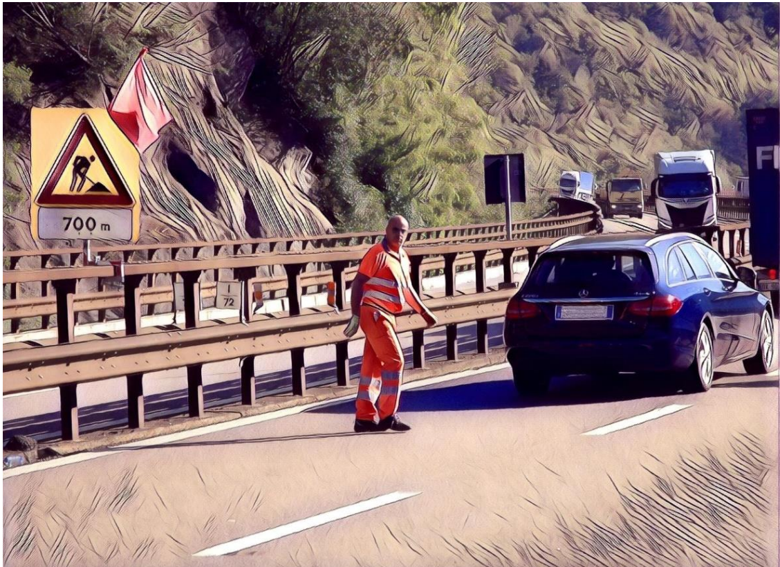
Chiusura della corsia di sorpasso: attraversamento di ritorno dopo l'installazione del segnale sul margine sinistro
