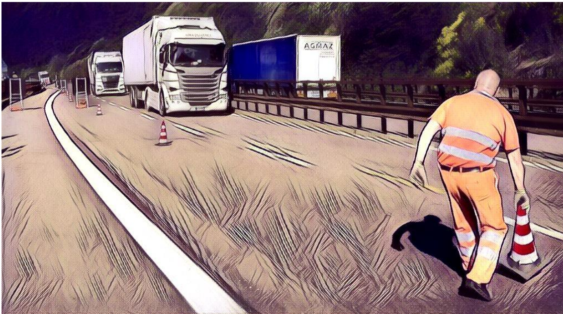
Chiusura della corsia di marcia: inizio della posa della delimitazione longitudinale
