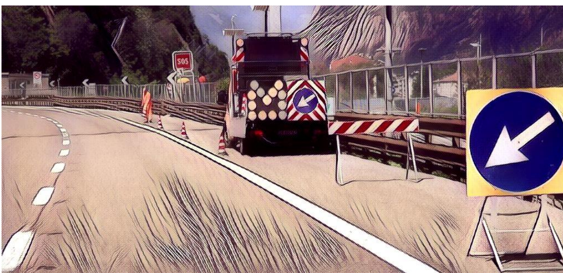
Chiusura della corsia di emergenza: posa della delimitazione longitudinale
