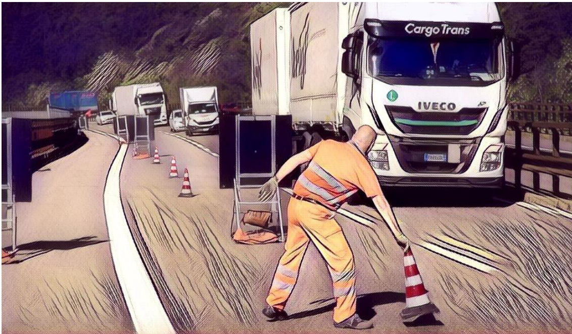
Chiusura della corsia di marcia: installazione della testata
