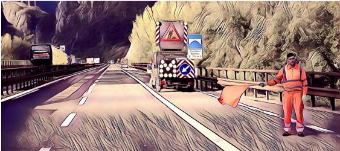
Chiusura della corsia di sorpasso: presegnalazione
