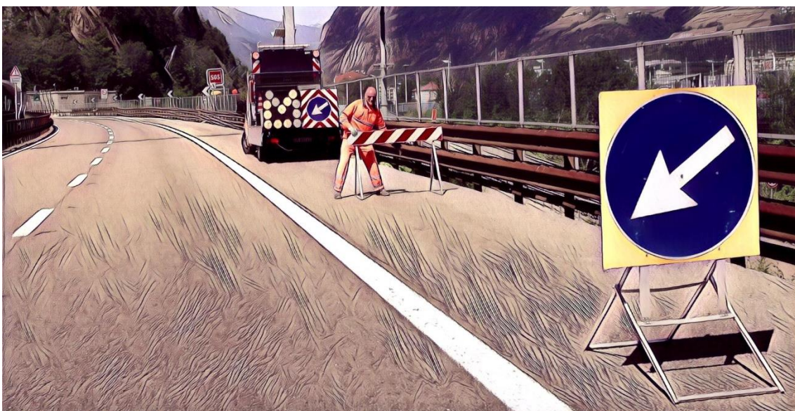
Chiusura della corsia di emergenza: posa della barriera normale
